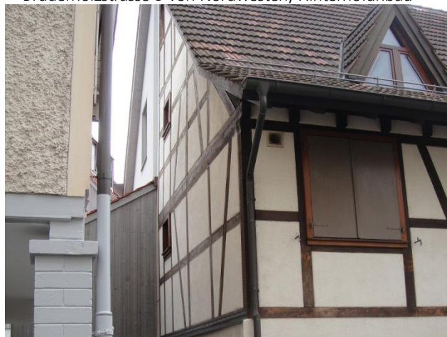
Bruderholzstrasse 5 von Nordwesten, Hinterhofanbau
