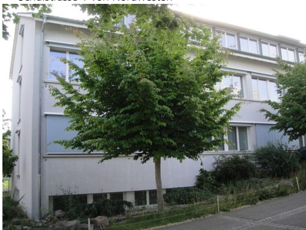
Schulstrasse 1 von Nordwesten
