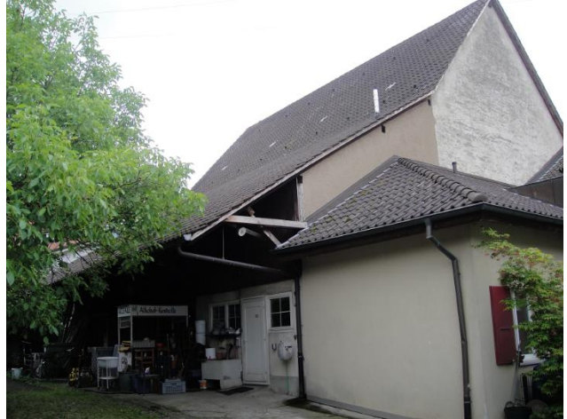
Bruderholzstrasse 11c von Nordwesten
