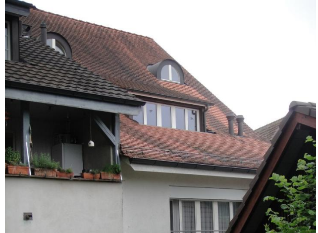
Weichselmattstrasse 5 von Nordosten
