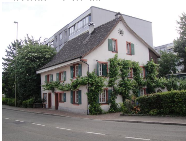
Baslerstrasse 26 von Südwesten
