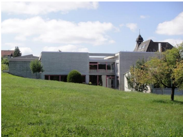
Schulstrasse 7 von Nordosten
