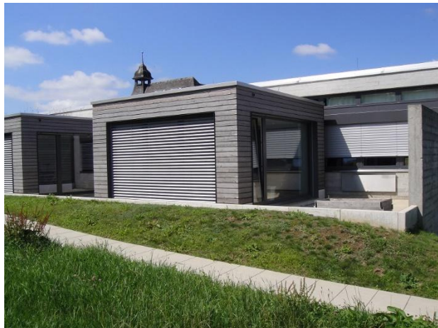
Schulstrasse 7 von Osten
