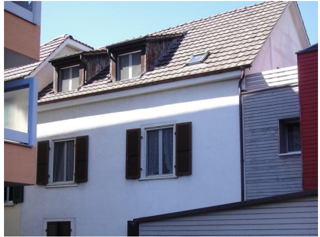
Ruchholzstrasse 22 von Osten
