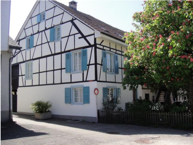
Bruderholzstrasse 18 von Osten
