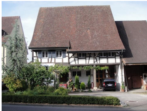
Bruderholzstrasse 24 von Nordosten
