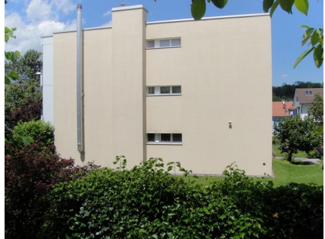
Talholzstrasse 1 von Süden
