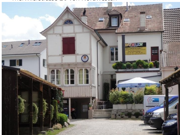
Therwilerstrasse 26 von Nordwesten
