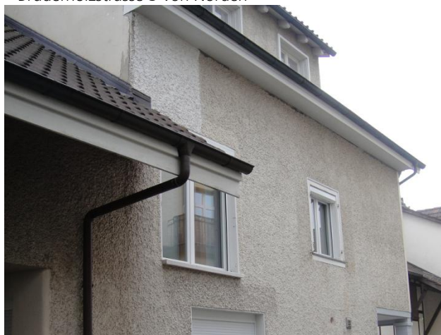
Bruderholzstrasse 3 von Norden
