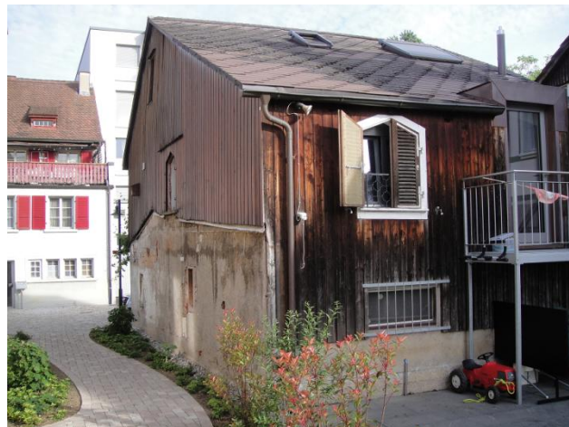
Bruderholzstrasse 10 von Süden
