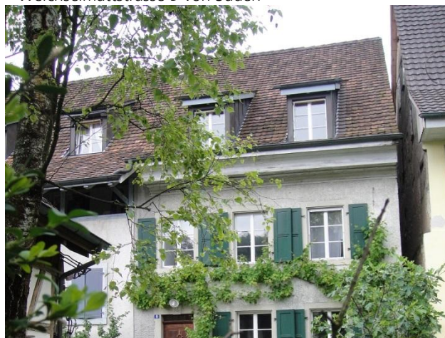
Weichselmattstrasse 9 von Süden
