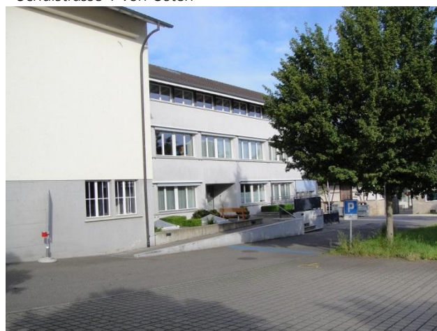
Schulstrasse 1 von Osten
