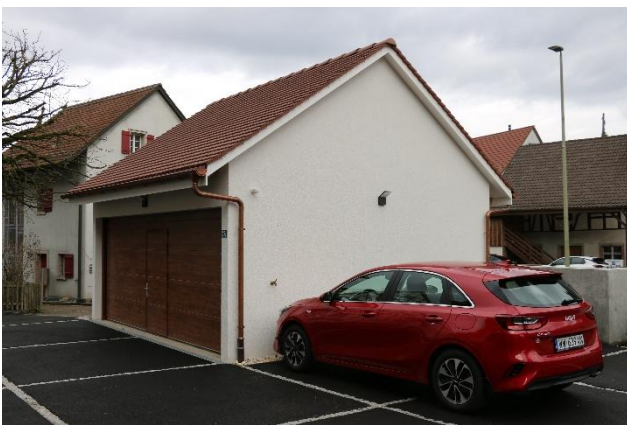
Bruderholzstrasse 22a von Südosten
