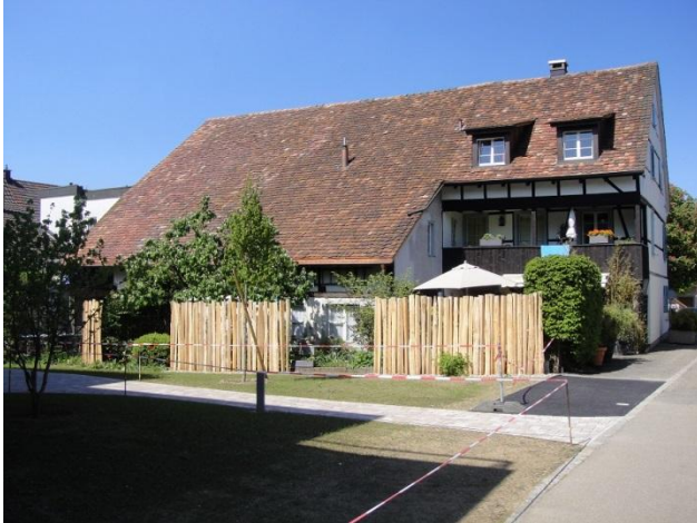
Bruderholzstrasse 18 von Süden
