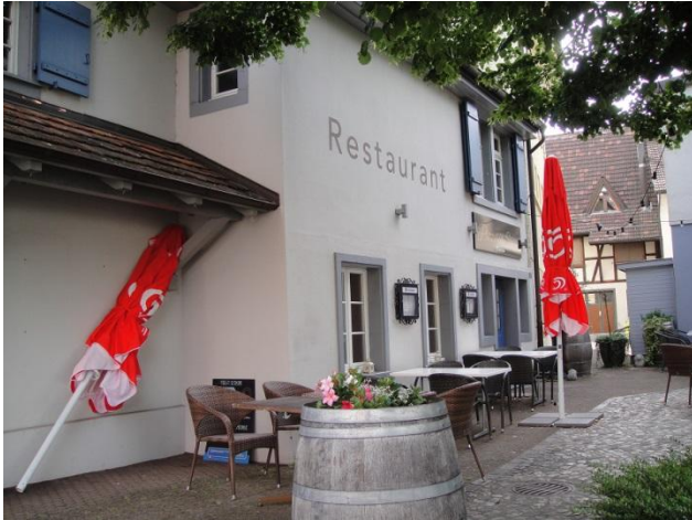
Baslerstrasse 4, Vorderhaus von Westen
