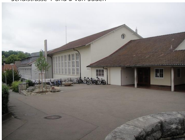
Schulstrasse 1 und 3 von Süden
