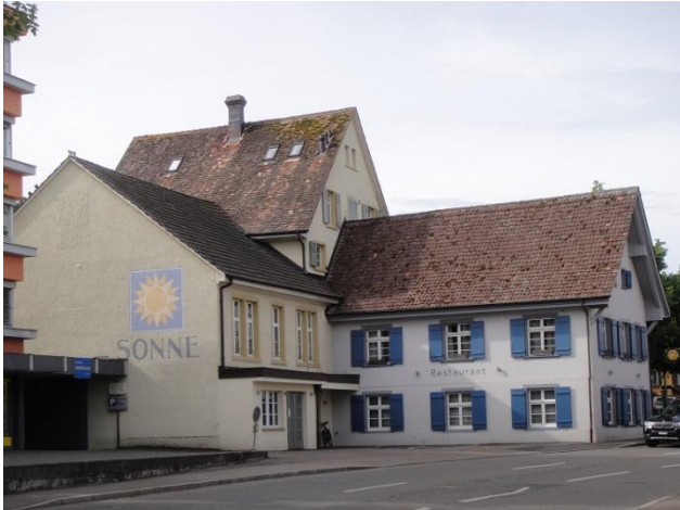
Baslerstrasse 4 von Norden
