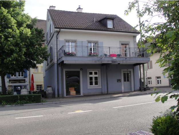
Bruderholzstrasse 1 von Südwesten
