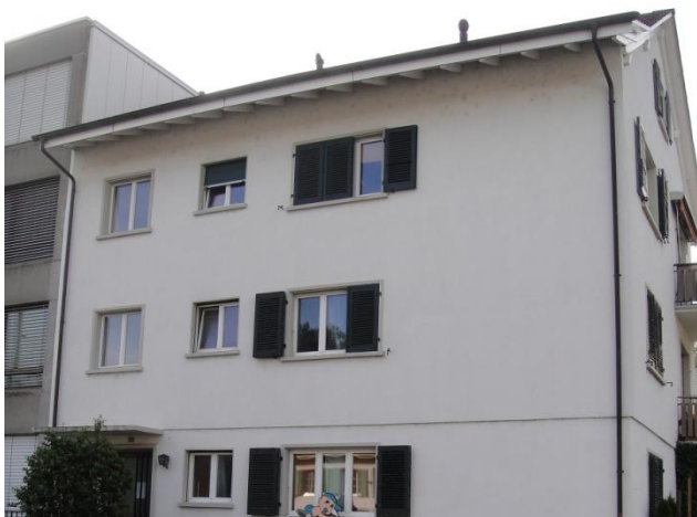
Therwilerstrasse 33 von Nordwesten
