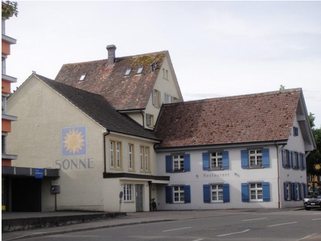
Baslerstrasse 4 von Norden
