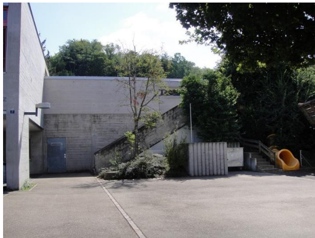
Schulstrasse 7 von Nordwesten
