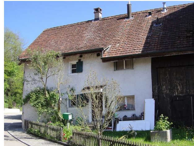
Weichselmattstrasse 6 von Westen
