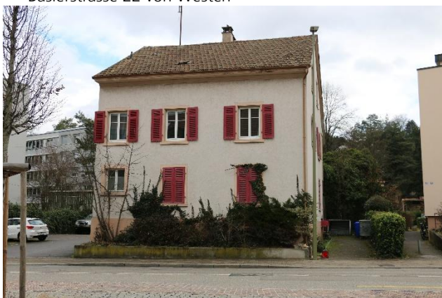
Baslerstrasse 22 von Westen
