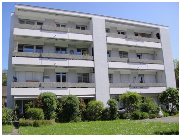
Baslerstrasse 11 von Westen
