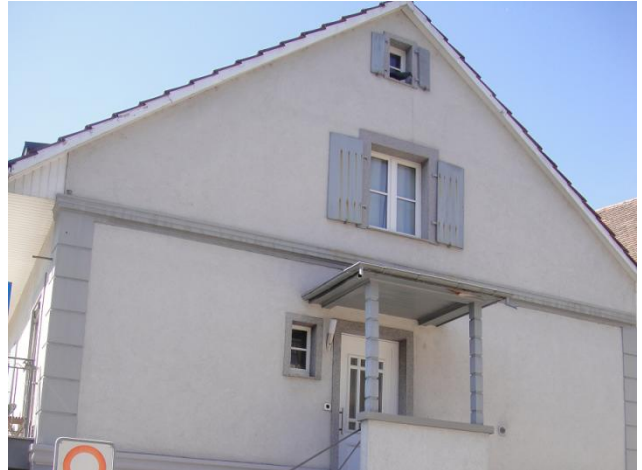
Bruderholzstrasse 1 von Osten
