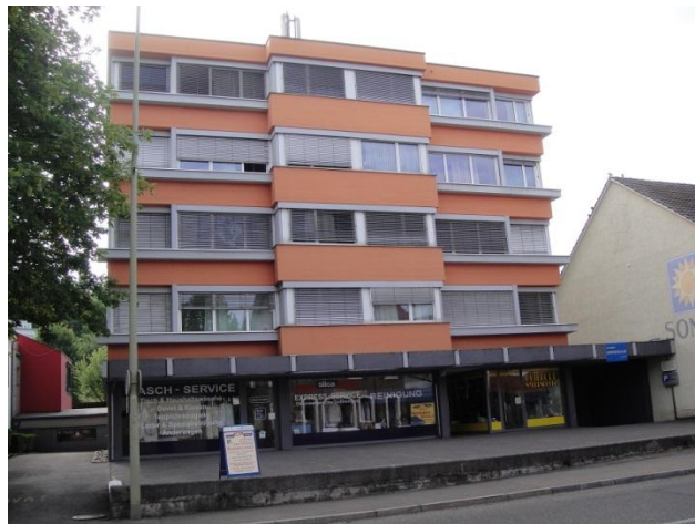
Baslerstrasse 6 von Westen
