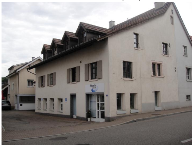
Bruderholzstrasse 5 von Südwesten, Hauptbau
