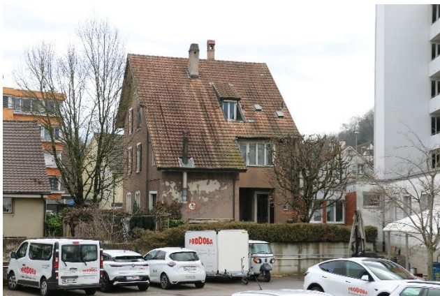
Baslerstrasse 5 von Westen
