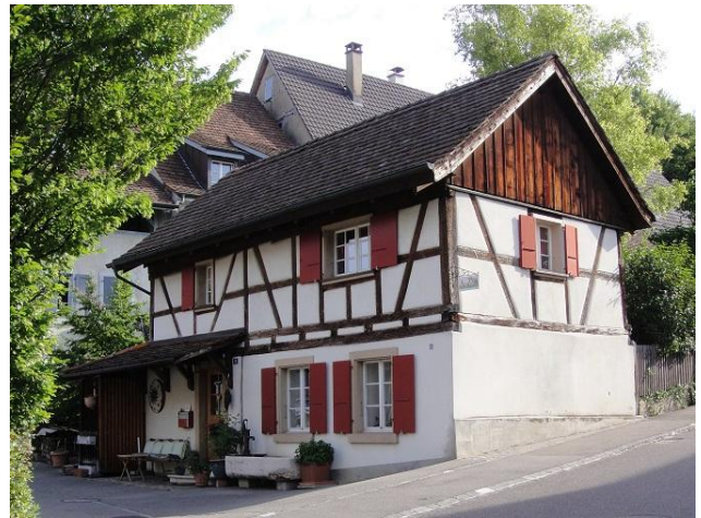
Weichselmattstrasse 11 von Südwesten
