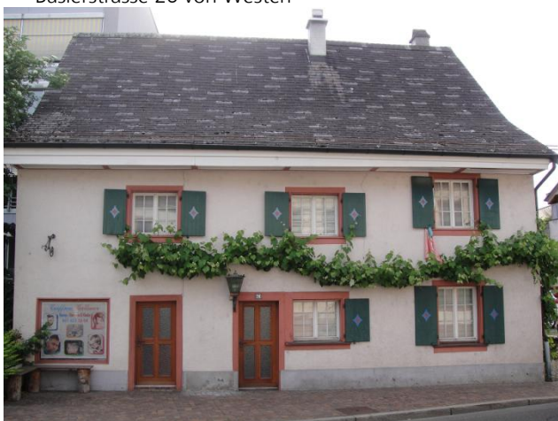
Baslerstrasse 26 von Westen
