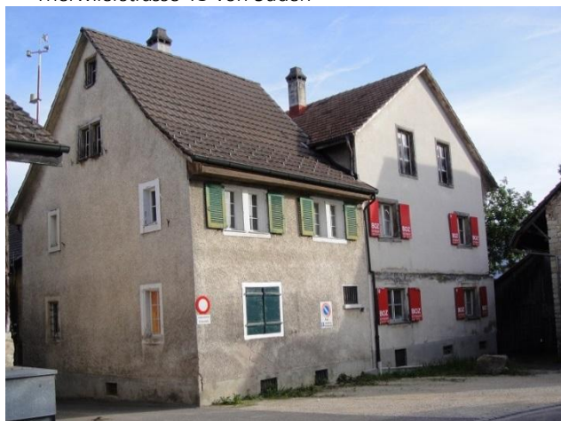
Therwilerstrasse 13 von Süden
