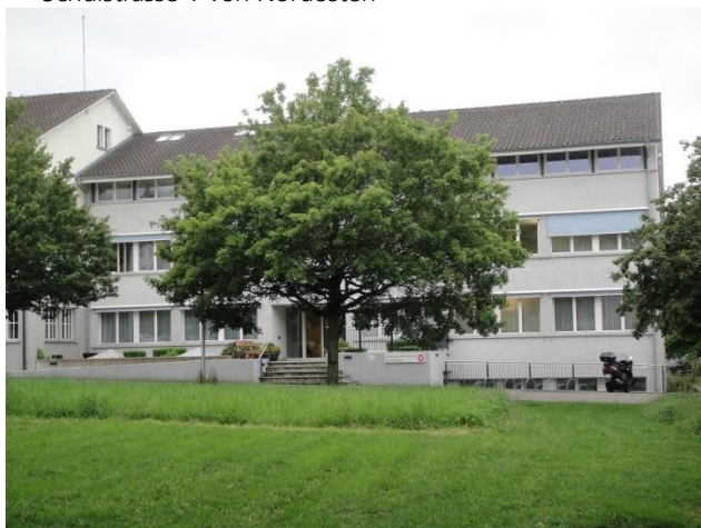
Schulstrasse 1 von Nordosten
