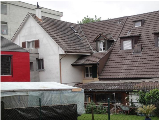
Ruchholzstrasse 22 von Osten
