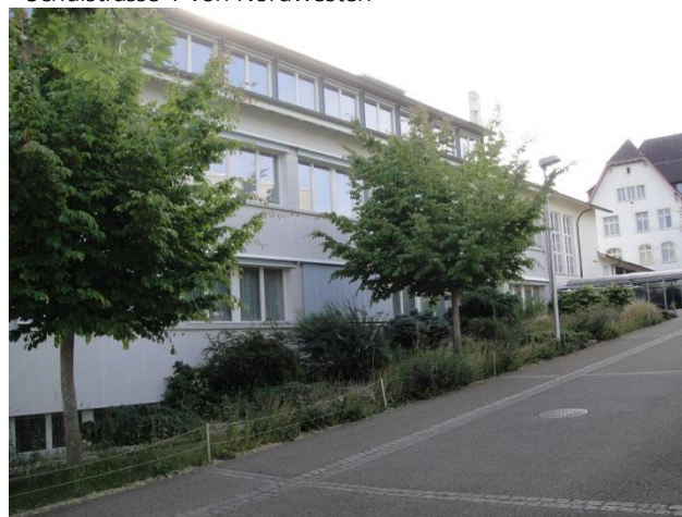
Schulstrasse 1 von Nordwesten
