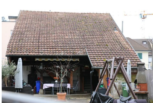
Baslerstrasse 15 von Westen
