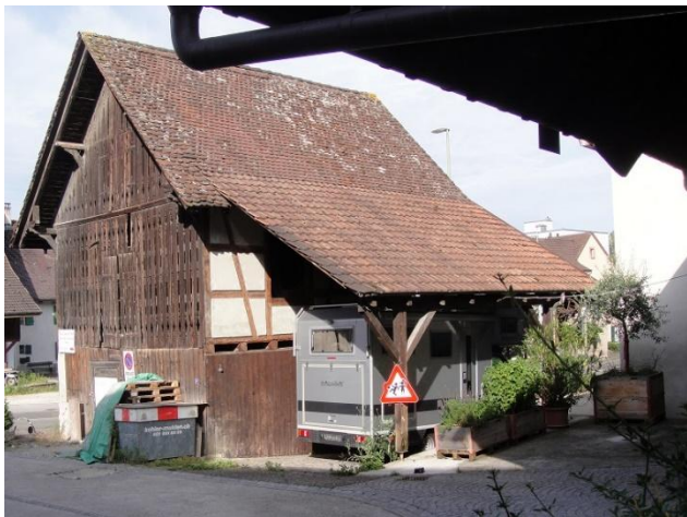
Bruderholzstrasse 11a von Osten
