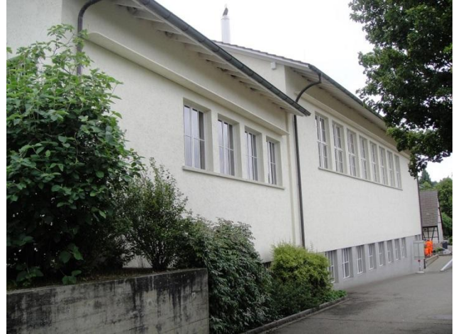
Schulstrasse 3 von Osten
