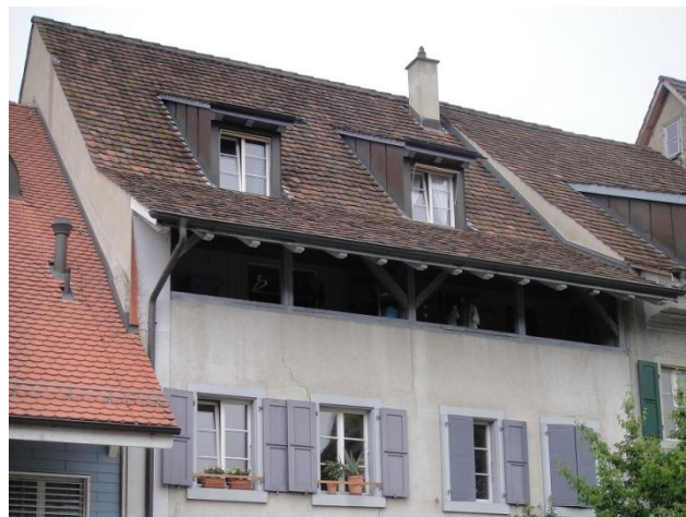
Weichselmattstrasse 7 von Süden
