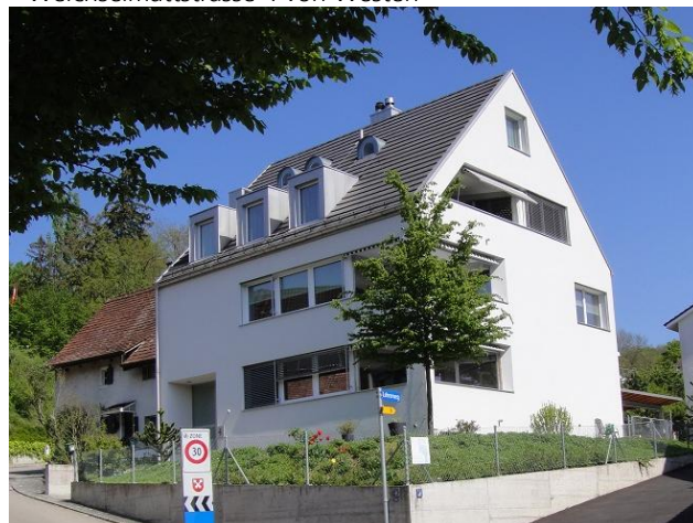
Weichselmattstrasse 4 von Westen
