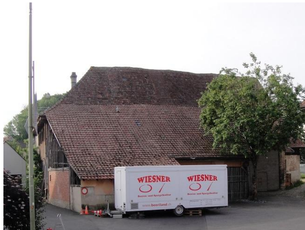
Therwilerstrasse 9 von Nordwesten
