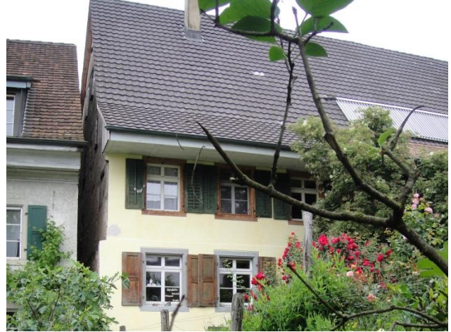
Weichselmattstrasse 13 von Süden
