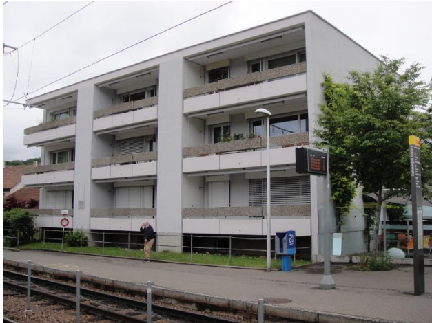
Baslerstrasse 13 von Westen
