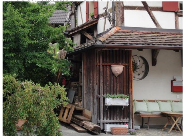
Weichselmattstrasse 11 von Südwesten
