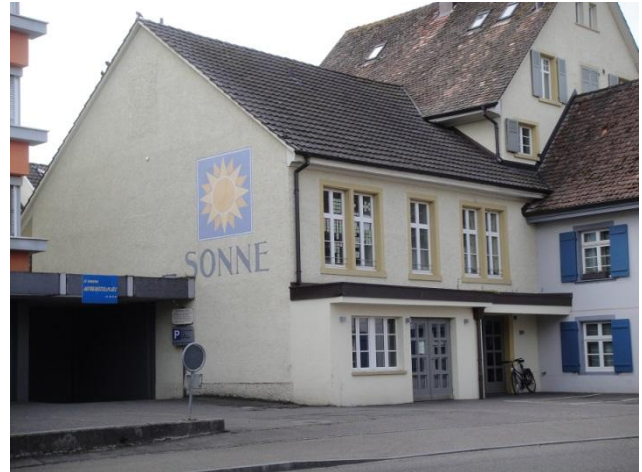
Baslerstrasse 4, Seitenflügel von Nordwesten
