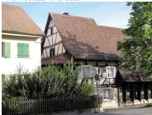
Therwilerstrasse 18 von Süden
