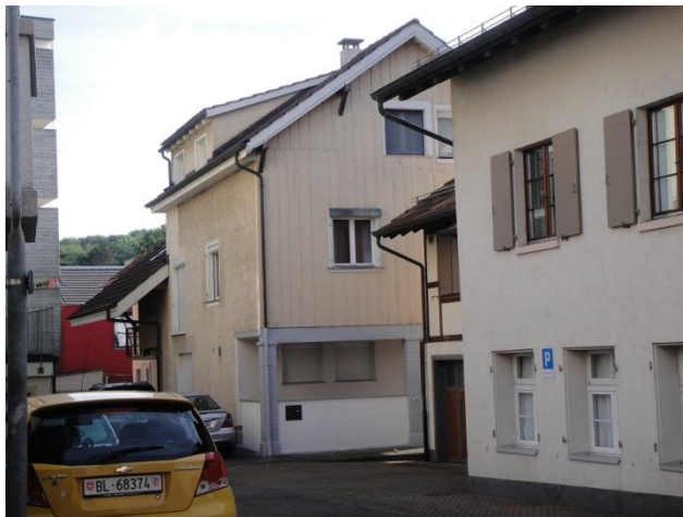
Bruderholzstrasse 3 von Südwesten
