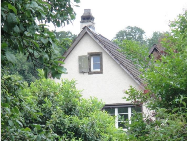
Bruderholzstrasse 13 von Norden
