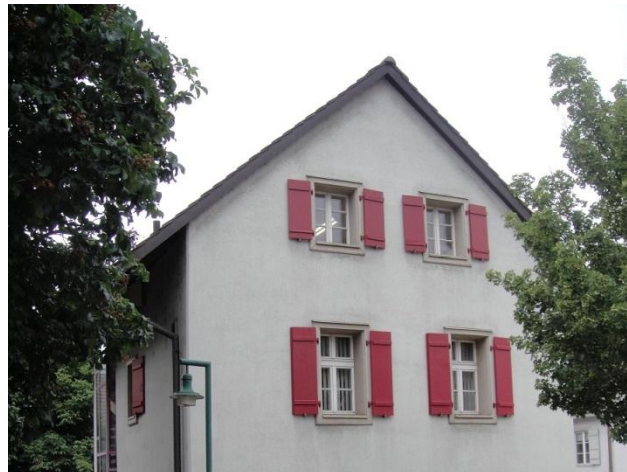
Bruderholzstrasse 20 von Osten
