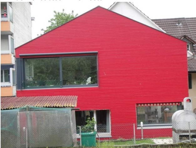
Ruchholzstrasse 22 von Osten
