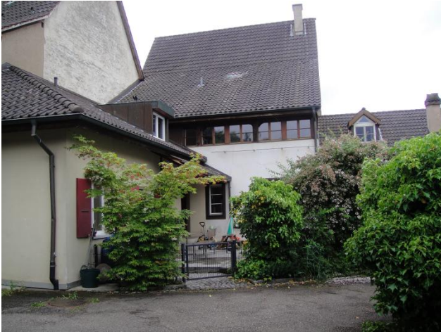
Bruderholzstrasse 11 c und d von Norden
