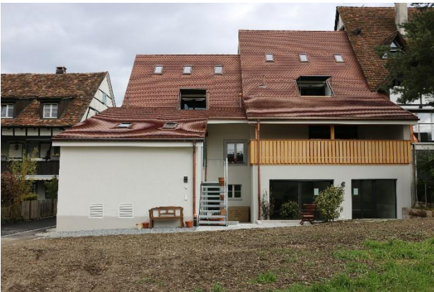
Bruderholzstrasse 22 von Süden
