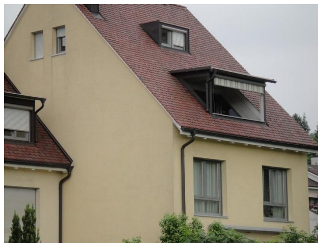
Bruderholzstrasse 28 von Südwesten
