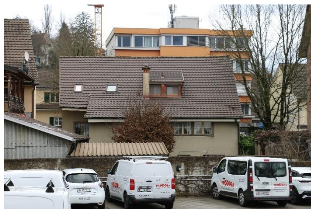
Baslerstrasse 7 von Westen
