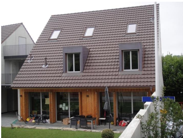
Weichselmattstrasse 2B von Osten
