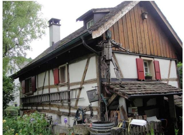
Weichselmattstrasse 11 von Nordosten
