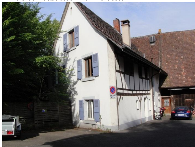
Weichselmattstrasse 1 von Nordosten
