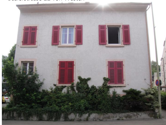
Baslerstrasse 22 von Westen
