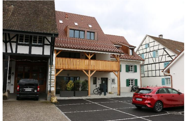
Bruderholzstrasse 22 von Nordosten
