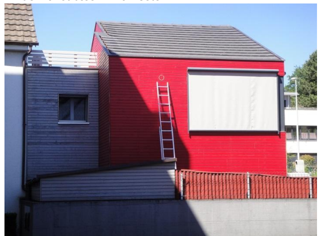
Ruchholzstrasse 22 von Osten
