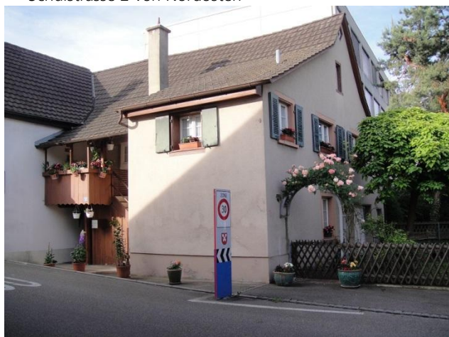
Schulstrasse 2 von Nordosten
