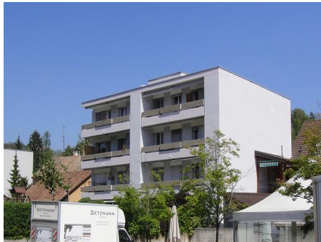
Baslerstrasse 11 von Südwesten
