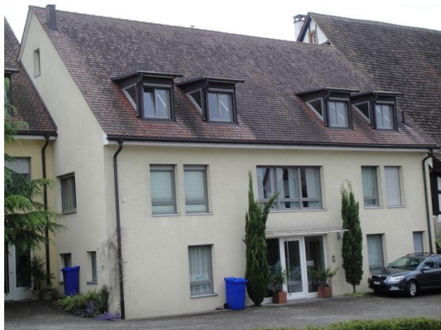
Bruderholzstrasse 26 von Osten
