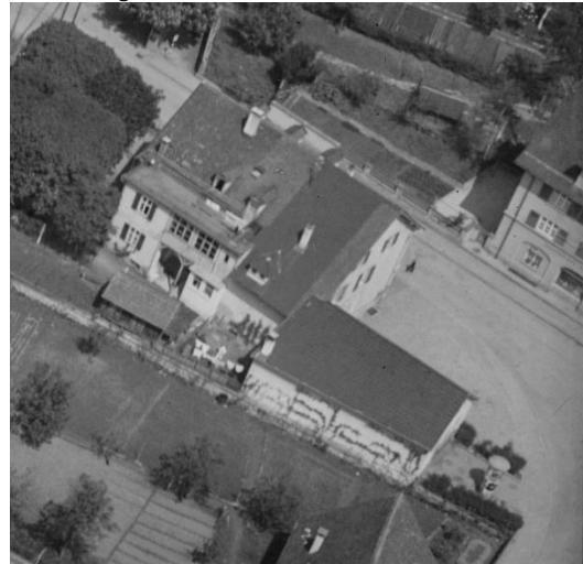
Schlossgasse 1 und 3 (Luftaufnahme 1940)
