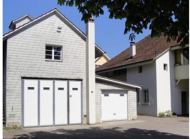
Therwilerstrasse 14a von Süden
