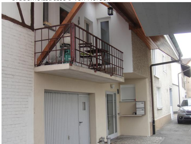
Bruderholzstrasse 3 von Norden
