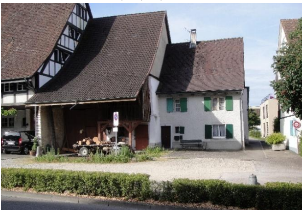
Bruderholzstrasse 24, 22, 18, Zustand vor 2024
