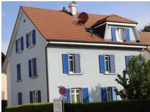
Therwilerstrasse 22 von Süden
