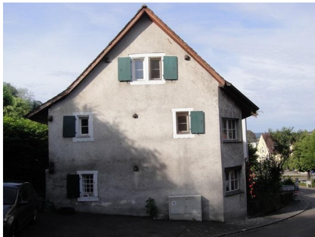
Weichselmattstrasse 6 von Nordosten
