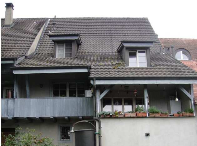
Weichselmattstrasse 7 von Norden
