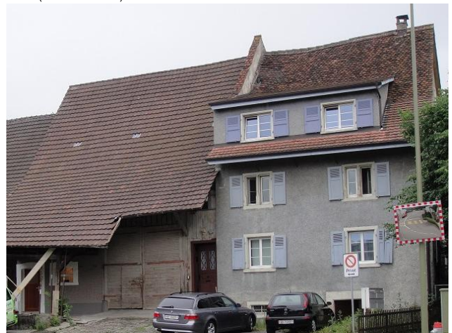
Bruderholzstrasse 15 Ökonomie und Weichselmattstrasse 3 (Wohnhaus) von Westen
