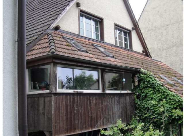
Bruderholzstrasse 13 von Nordosten
