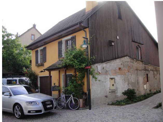
Bruderholzstrasse 10 von Südwesten
