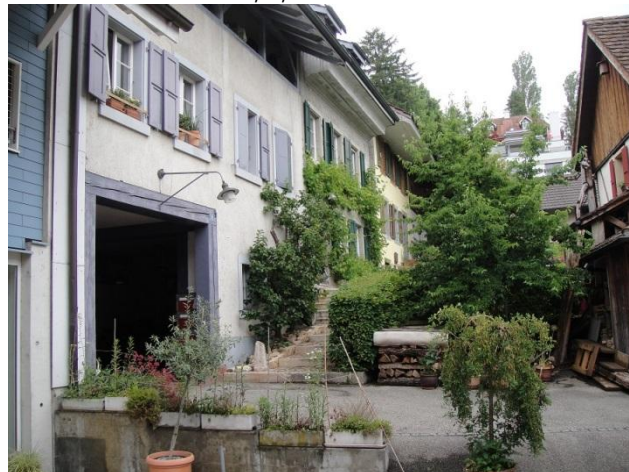
Weichselmattstrasse 7, 9, 13 von Südwesten
