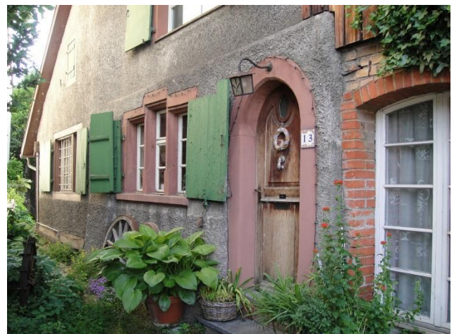
Bruderholzstrasse 13 von Südwesten
