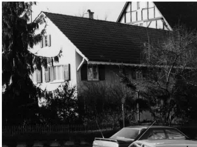
Bruderholzstrasse 26, altes Gebäude
